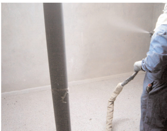
Obr. 3.27. - Průběh procesu nanášení elastomerového materiálu stříkáním
